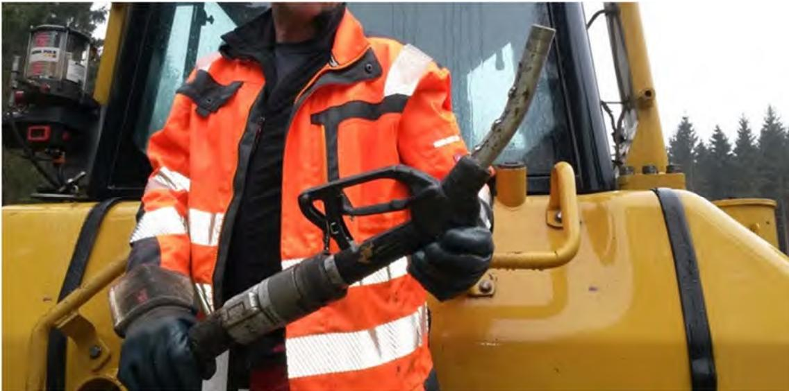
Abbildung 4: Empfohlene Maßnahme: Betankung von Baugerät mit rückschlaggesicherter Zapfpistole.
