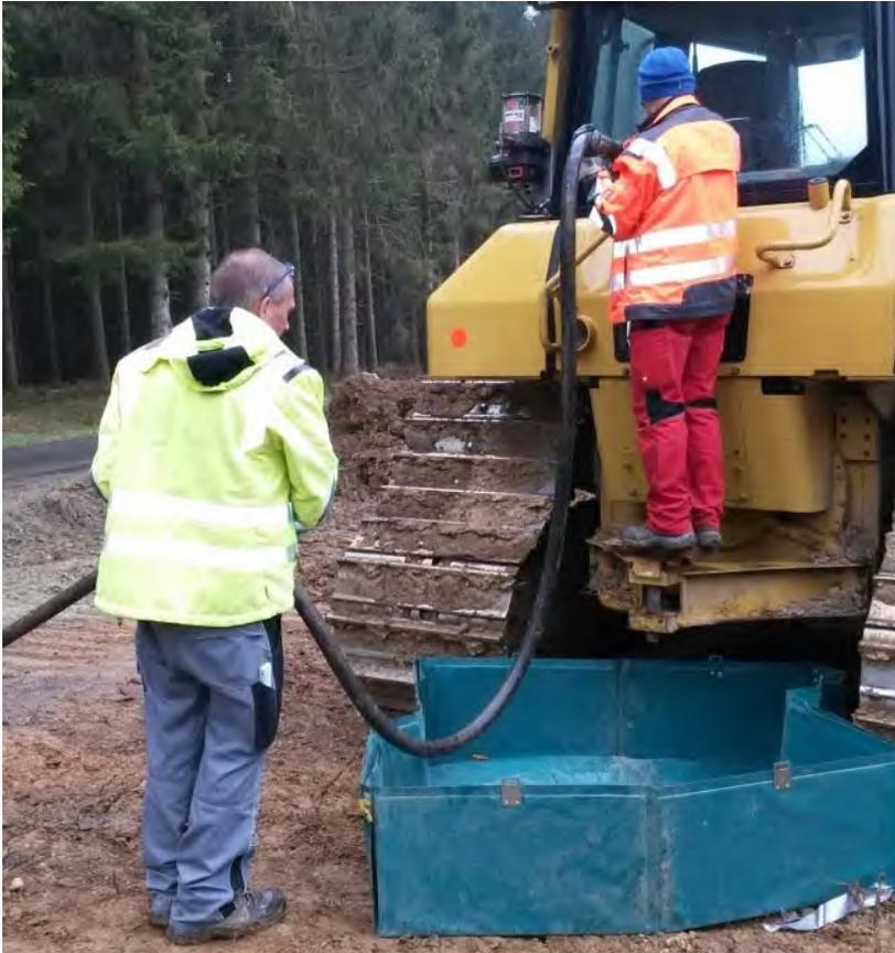
Abbildung 5: Empfohlene Maßnahme: Betankung der Baumaschinen im Bau Feld von 2 Personen mit faltbarer Auffangwanne.
